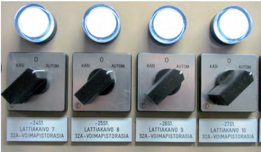
Vikavirtasuojatut pistorasiat voidaan ohjata päälle käsin tai valvomosta.
